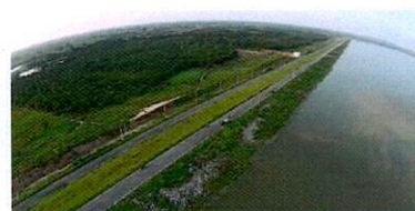
เขื่อนรัชชโรธร เขานางนม อ่างเก็บน้ำคลองหลวง
